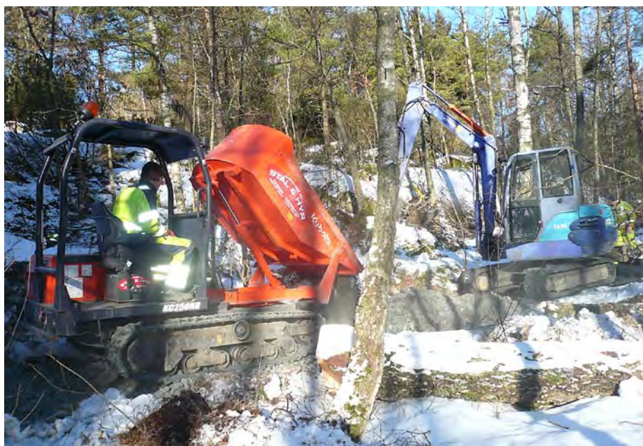
Grävskopan tar vid och jämnar till bärlagret
